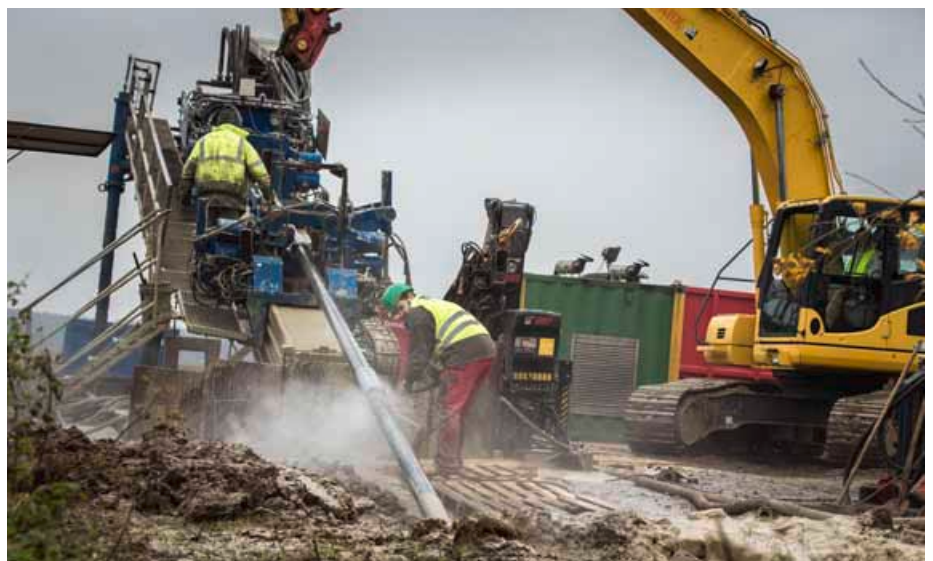
Ein modernes Verfahren, die Kreiselkompass-Steuerung, erlaubt ein sehr genaues Steuern des Bohrkopfes.
