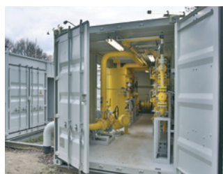
Mobile GDRM 1 „MOA“ Eing.: DN 100 ANSI 600 (MOP 70) Ausg.: DN 150 ANSI 300 (MOP 25) Vn = bis zu 20.000 m 3 /h
